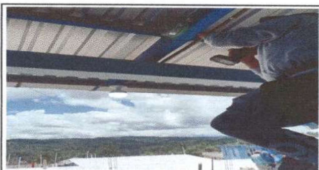
Foto 11: Reparación de plafoneras y lamparas
