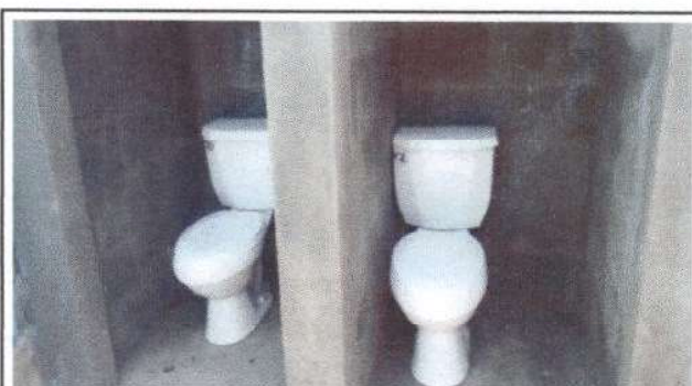
Foto 10: Cambio de Sanitarios
