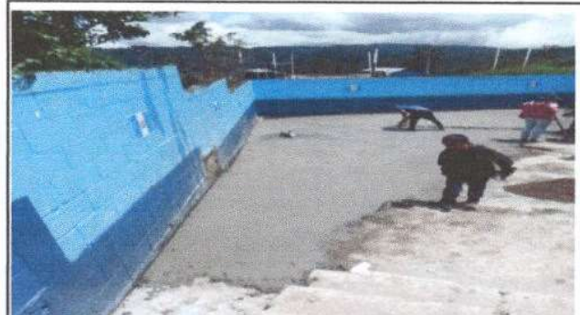
Foto 4: Sustitución de piso de torta de concreto en la parte del patio del primer modulo
