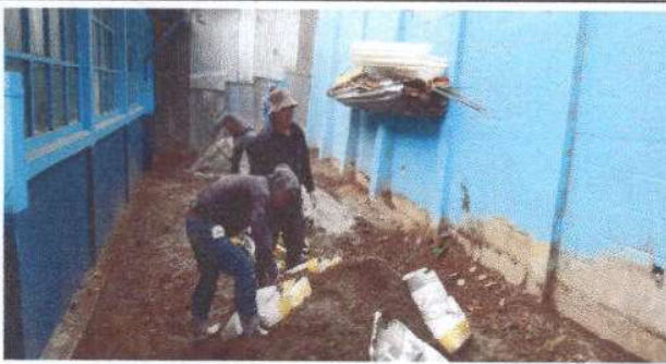
Foto1: Sustitución de piso de torta de concreto en la parte de atrás de la escuela
