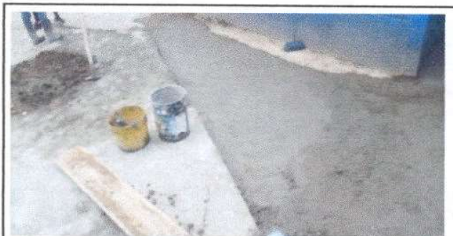
Foto 5: Reparación de piso.
