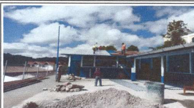
Foto 8: Cambio de Lamina
