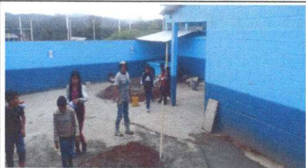
Foto 2: Sustitución de pila de 2 lavaderos
