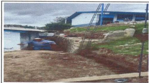
Foto 3: Reparación de muro.
