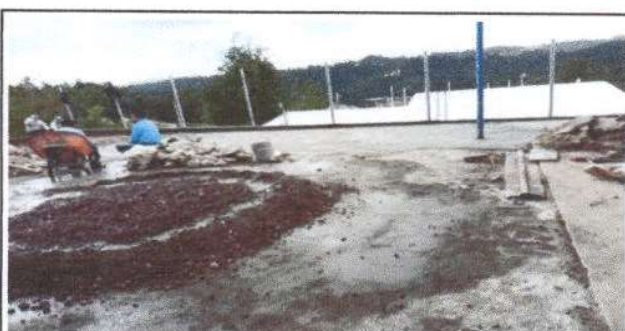
Foto 6: Reparación de piso.
