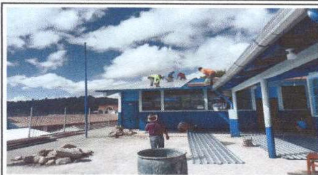
Foto 7: Cambio de Lamina
