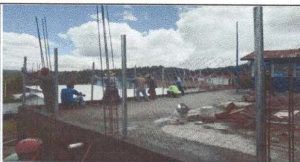
Foto 5: Reparación de tubo hg y malla galvanizada
